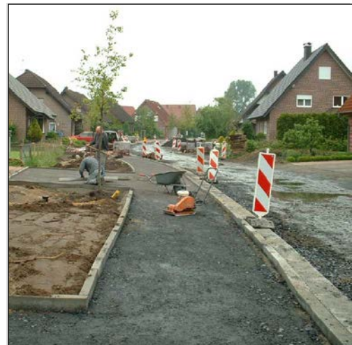
Bordanlage Südlohner Diek
