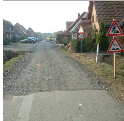
vorh. Baustraße (gefräster Asphalt)
