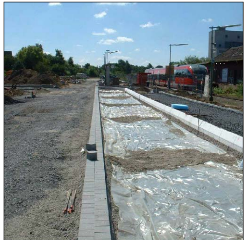
Vorbereitung der Betontragschicht Busbucht
