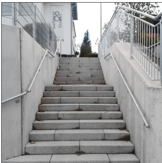
neue Treppe aus gestockten Betonstufen
