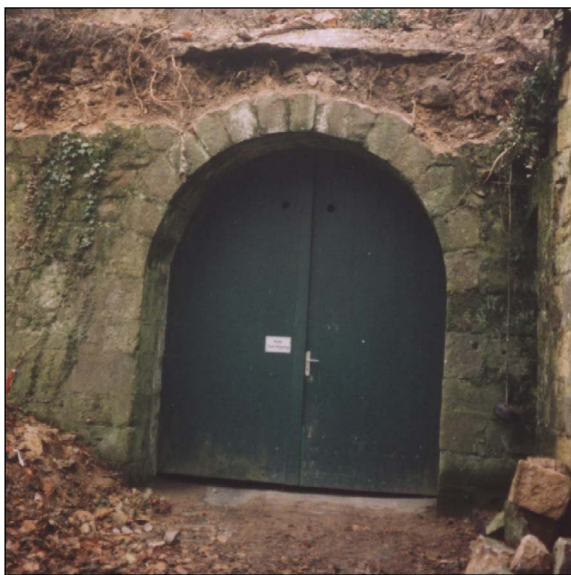
Südlicher Torbogen vor der Sanierung
