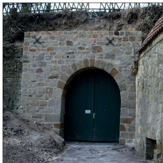
Südlicher Torbogen nach der Sanierung
