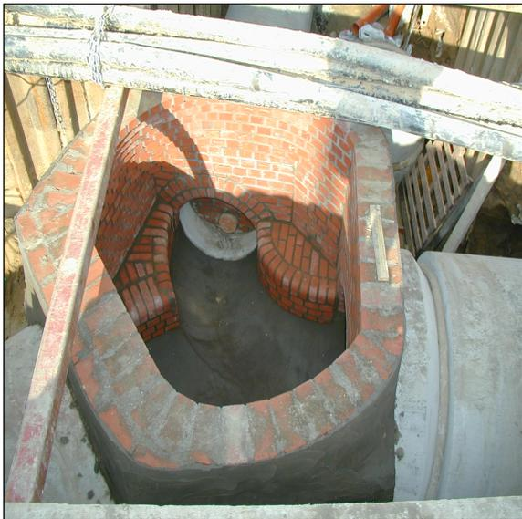
Gemauerter RW-Schacht mit 2 Kanälen (DN 1200 und DN 800)
