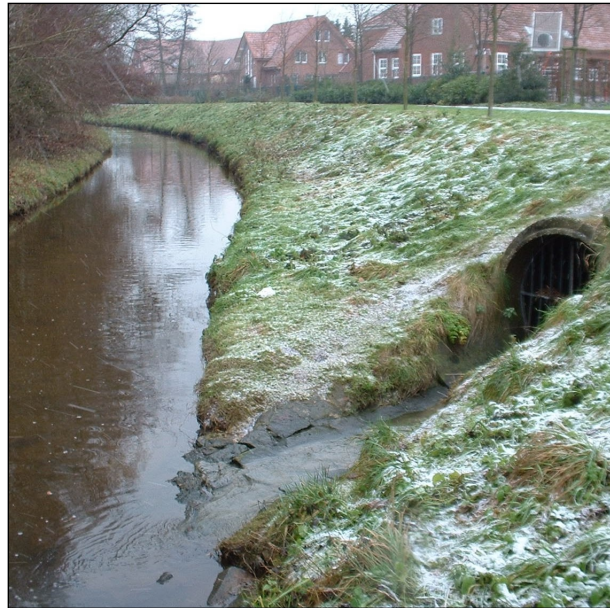
Hydraulische Überlastung des Gewässers durch Einleitungen
