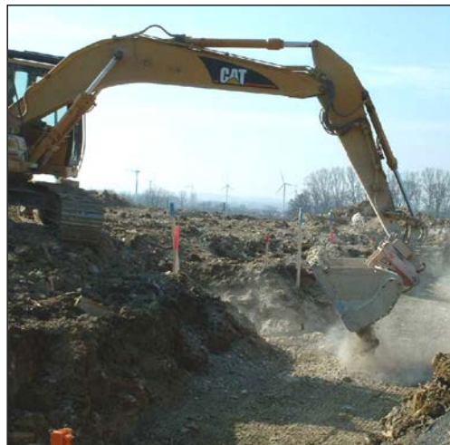
Rohrgrabenverfüllung mit Kalkzusatz mittels Separator
