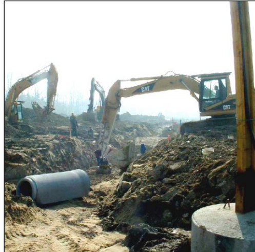
Erdarbeiten im Kanalbau
