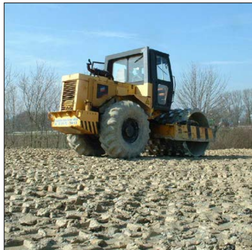
Verdichtung des Lärmschutzwalls mittels einer Schafsfußwalze
