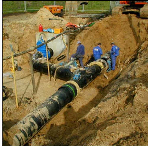
Einführung der Molchstation
