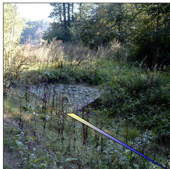
Umgestaltung der Einleitung
